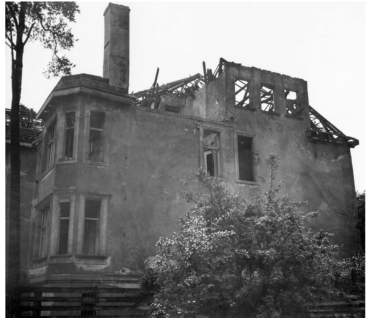
13 Ruine von Aschers Versteck in Berlin, Lassenstraße 26 | Bombed-out Building Lassenstraße 26
